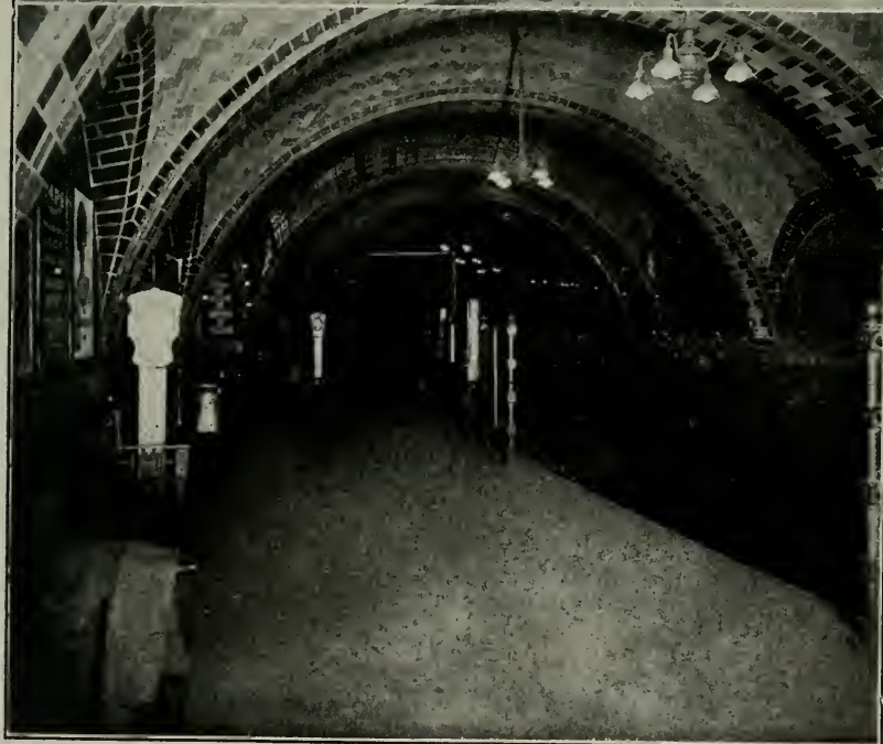
Entrada al Subway e interior de uno de sus tramos. Aunque aquí sólo se ve una vía, generalmente el Subway tiene dos y cuatro vías.
